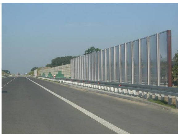
Zdjęcie 2 i 3 Przykłady ekranów ochrony akustycznej, autostrada A4 i Poznań - Kórnik DK 11 (www.zinfo.pl, www.gddkia.gov.pl)
